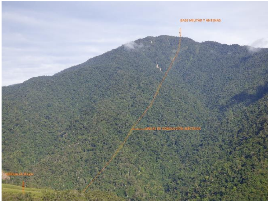
Figura 6. Localización línea eléctrica en terreno dentro del Parque
