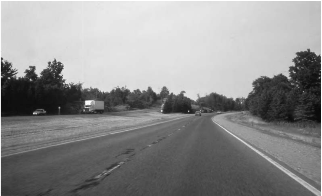
Gráf. 7-2 Una brecha angosta de hábitat inadecuado u hostil, como una autopista concurrida, puede limitar con más eficacia los desplazamientos de animales que una extensión amplia de hábitat de escasa calidad. (Foto: A. Bennett).
