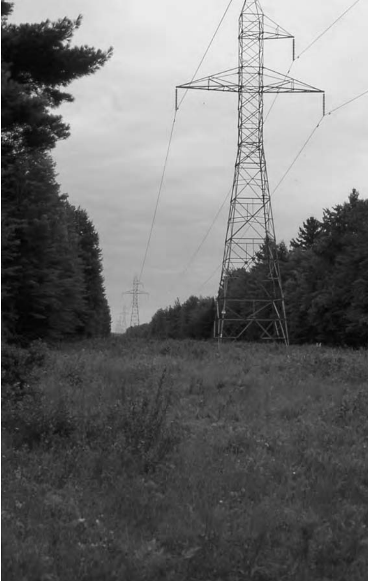
Gráf. 4-3 Los claros para líneas de transmisión son ejemplos de corredores perturbados que se mantienen debido a intervenciones humanas continuas. Cerca de Ottawa, sur de Ontario, Canadá. (Foto: A. Bennett).
