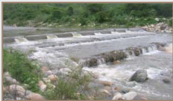
Fig 6. Captación del sistema de riego en Piedra del Toro - Piura, que incorpora el concepto de resiliencia (flexible para épocas de escasez y abundancia de agua).
