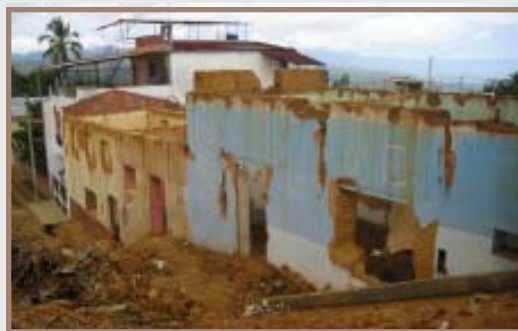
Fig. 5. Vivienda destruída en terremoto de Lamas (setiembre 2005).
