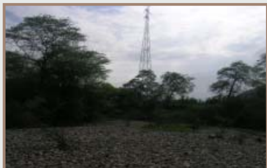
Fig. 3. Ejemplo de vulnerabilidad - exposición: torre de alta tensión ubicada cerca a una quebrada.
