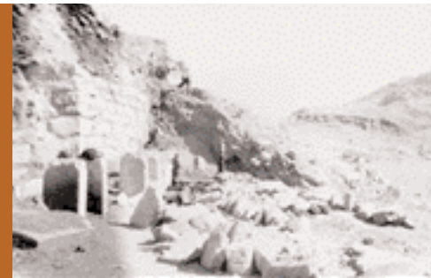
Reexcavación de las fachadas de los edificios de Chavín en 1956.
