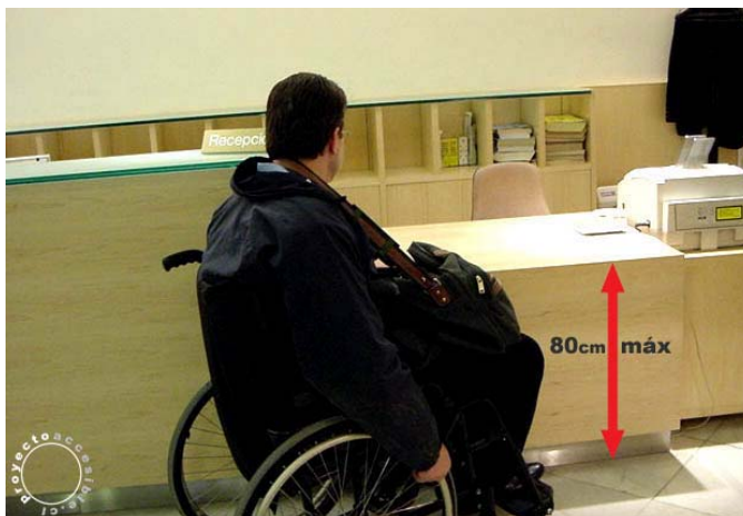
Foto 22: Altura máx. de mesón de recepción.
