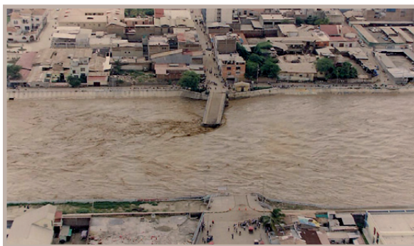
Destrucción del puente Bolognesi cuya recuperación tuvo un costo de inversión de S/. 23 millones y tardó un periodo de 12 meses, Piura (FEN 1997-1998). [Fotografía: Diario El Tiempo, Piura]
