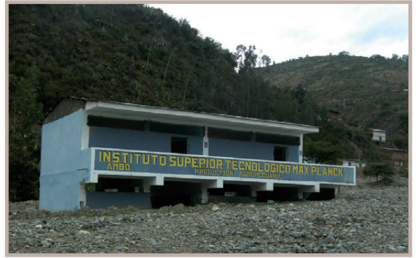
La población se ubicó en una quebrada y las inversiones para que accedan a servicios básicos se expusieron al mismo peligro. Al activarse la quebrada, se generó un huaico que arrasó con las viviendas y, entre otros, con la institución educativa que se observa en la imagen.
