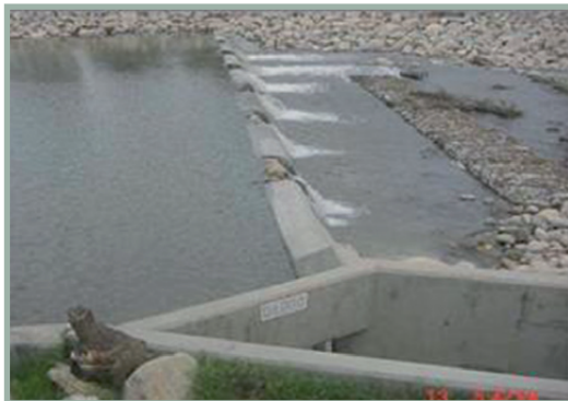
En el diseño del sistema de riego se incluyó medidas para el manejo de caudales que minimizan el riesgo para la estructura de captación cuando los caudales son máximos y favorecen la toma continua de agua cuando los caudales son mínimos.
