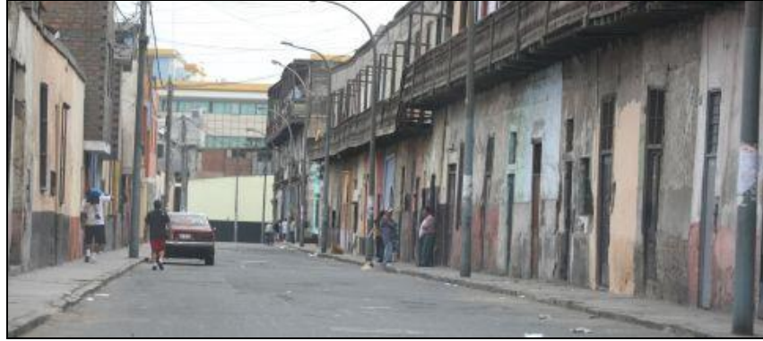
IMAGEN 16: Viviendas inadecuadas o precarias en el centro de Lima
