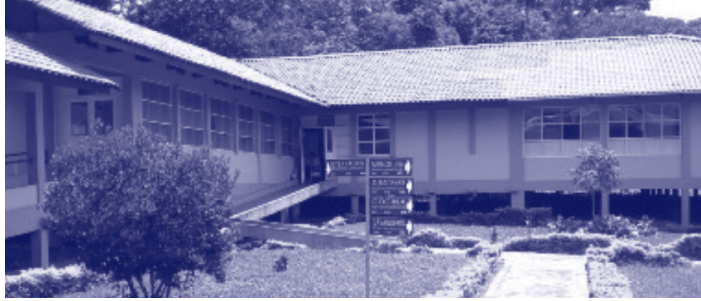
Edificio construido con medidas de mitigación ante inundaciones.
