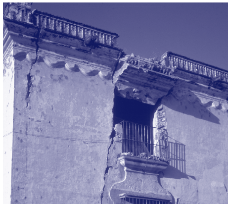
Cuando el suelo se expande por presencia de humedad, puede provocar rajaduras en pisos y muros.
