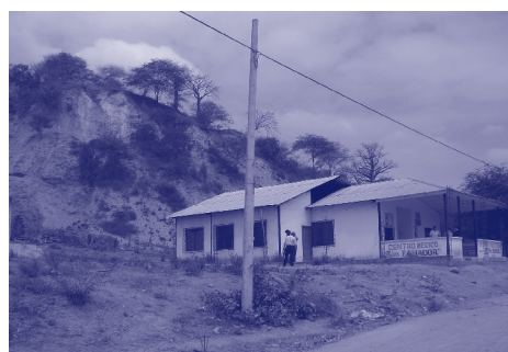
Un establecimiento de salud ubicado sobre un terreno inestable o cerca de él se encuentra expuesto a resultar seriamente afectado.
