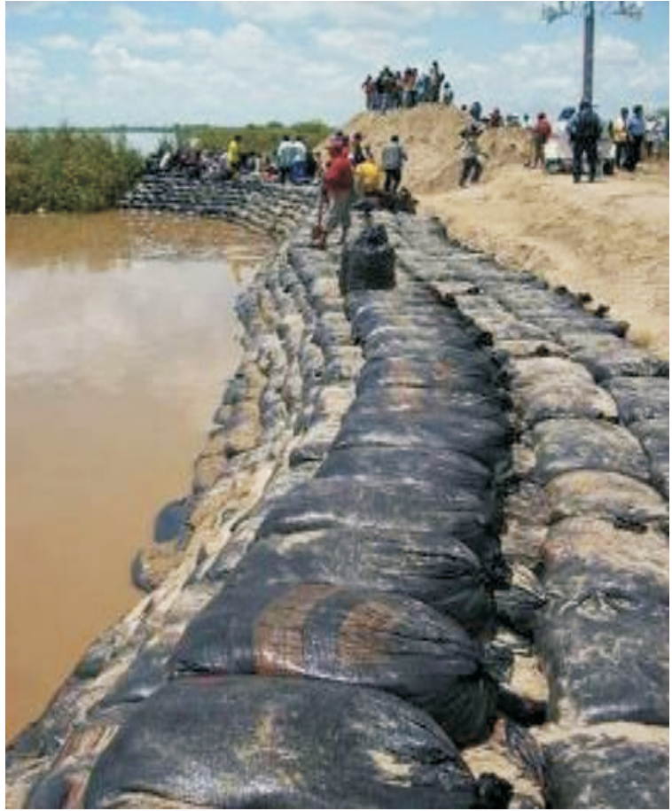
Proceso de llenado de sacos terreros y refuerzo de laderas de río
