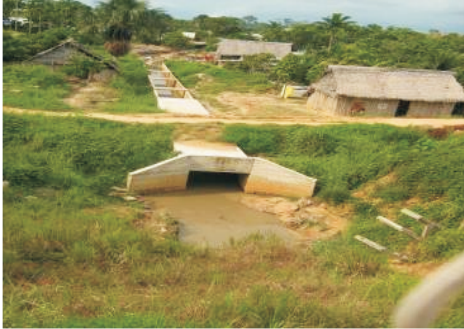
Canal de drenaje, aguas pluviales - Yurimaguas
