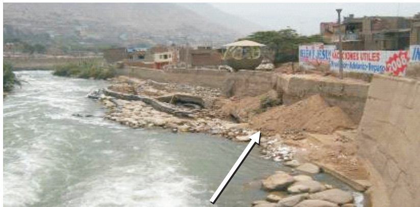
Muro de concreto ciclópeo del A.H Cantagallo – Distrito de Chosica
