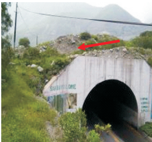
Cause del río seco que pasa sobre el túnel San Bartolomé ubicado a la altura del Km. 56 de la Carretera Central.
