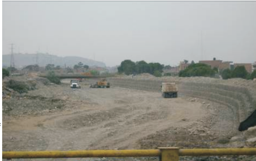
Sistema de gaviones sector los Olivos Río Chillón - Limpieza general
