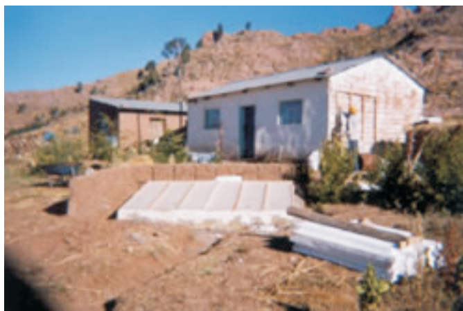
Fig. 3. Uno de los 7 prototipos que SENCICO construyó experimentalmente en la localidad de Jaylihuaya
