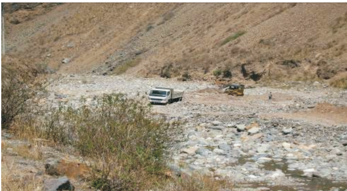
Río Rímac, sector de Tambo de viso limpieza y descolmatación
