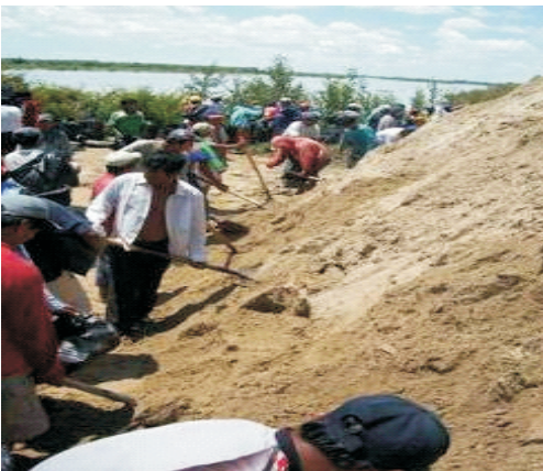
Proceso de llenado de sacos terreros y refuerzo de laderas de río
