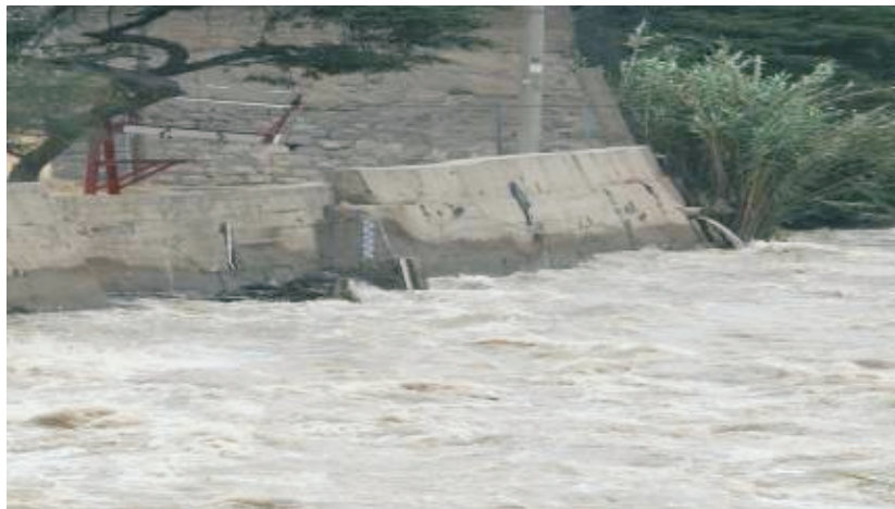
Muro de concreto armado – Chosica sector Moyopampa
