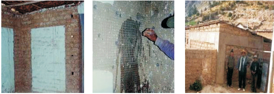
Eliminación del tartajeo y instalación de conectores tarrajeo final Perforaciones de muro y malla
