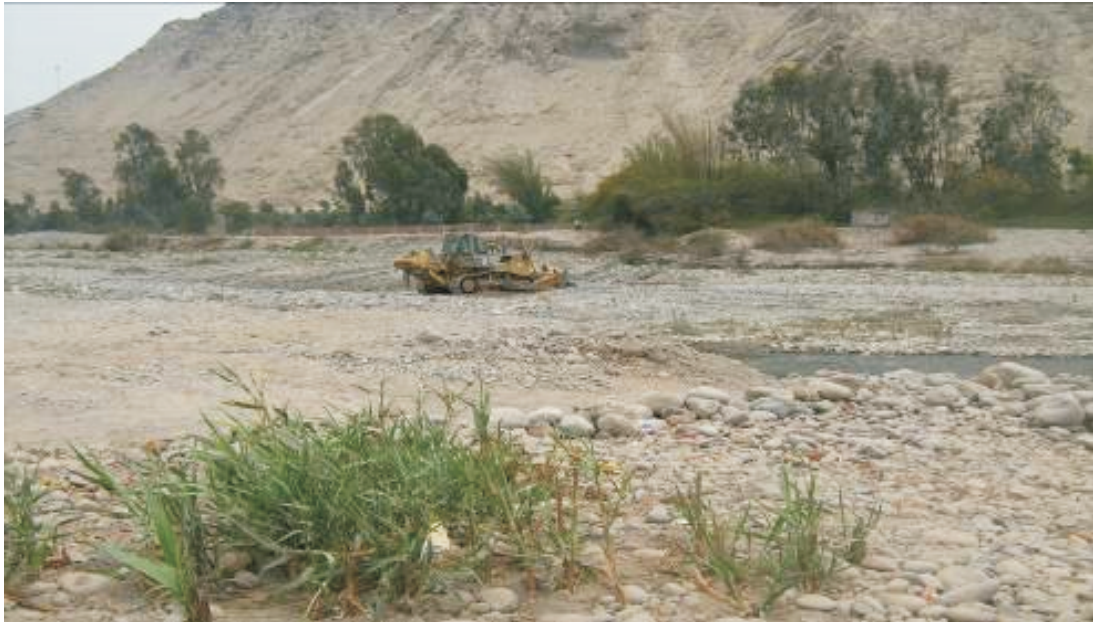
Refuerzo de diques secos erosionados, en el cauce del río Lurín, sector Cieneguilla
