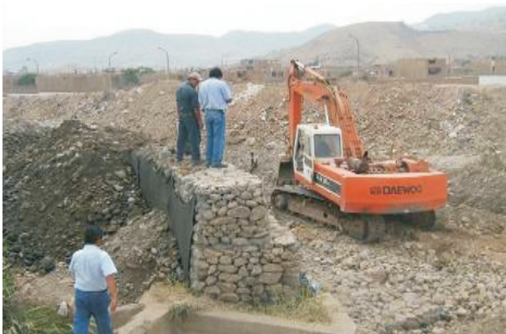
Limpieza final del cauce del río en la parte más alejada al gavión
