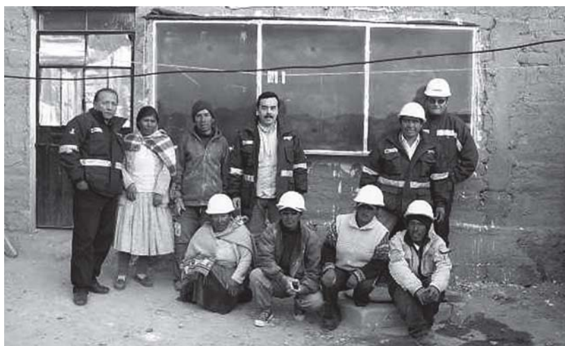
Calefactor Solar N° 650 Arequipa: 7 de agosto de 2009. localidad de Imata, distrito de Antonio de Chuca, provincia de Caylloma, Arequipa. Hincados la cuadrilla de instalación con la presencia de una mujer Blanca Apaza Choque, Gabina Choque Condori, David Huachani Mayta y Nicolas Chite Choque. Arriba parados entre los trabajadores de SENCICO los esposos beneficiarios Teodora Quispe Arisaca y Bibiano Quispe Caillahua, quienes tienen 4 hijos menores de 12 años.
