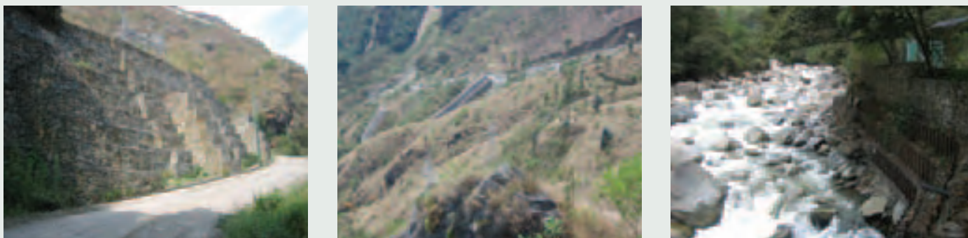
Ilustración 15. Obras de defensa en el río Aobamba
