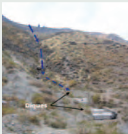
Ilustración 4. Diques de la quebrada de Huarca, San Mateo. Izquierda: En la quebrada de Huarca, San Mateo, se procedió a la construcción de dos diques que cuentan con una capacidad de retención de 970 m 3 ante el peligro de huaicos. Derecha: Los diques de la quebrada de Huarca posibilitan la prevención y ponen en alerta a la población de las áreas urbanas ante la proximidad de una avenida de huaicos (identificados en azul) en periodos de precipitaciones.
