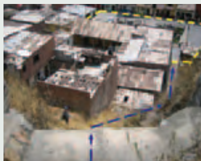
Ilustración 8. Riesgo subsistente para la población en el distrito de Matucana A pesar de la construcción de los diques en las laderas, ante el desarrollo de un huaico (identificado en azul), la Plaza de Armas de Matucana (identificada en amarillo) es altamente vulnerable, debido a que ni la municipalidad ni la población organizada cumplen con mantener descolmataados los diques, lo que ocasiona la posibilidad de inundación de la localidad, así como pérdidas humanas y daños materiales. (Vista desde la quebrada de Chihuanpunco.)
