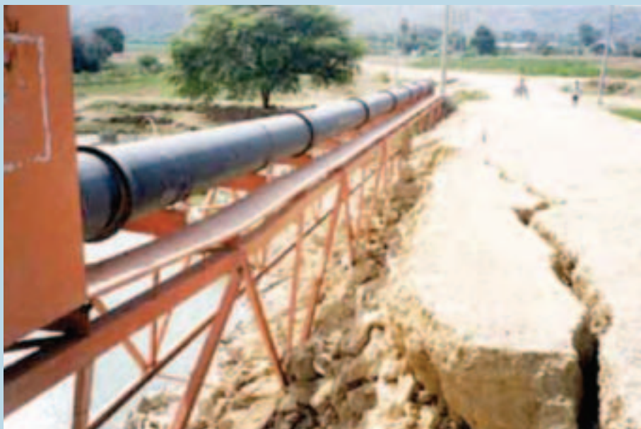
Foto 6. Eje Paita-Talara: tubería de conducción
