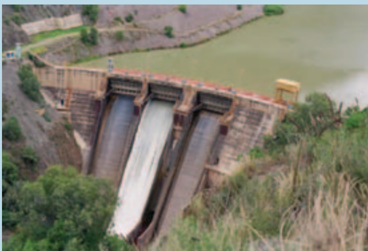
Foto 2. Embalse Tablachaca: presa
